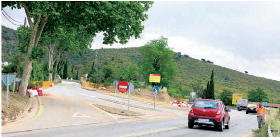
Aspecte actual del tram on es construirà la rotonda que millorarà la connexió entre la carretera de la Roca i la de la Vallencana
