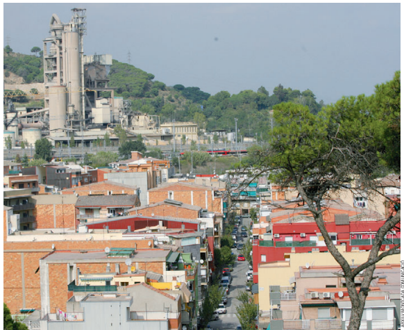
En aquesta imatge es pot apreciar la proximitat existent entre els habitatges de Can Sant Joan i la planta muntacadena de Lafarge Cementos
