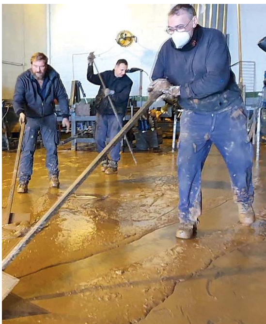
Treballadors de Sermetalfe, netejant de fang la nau de l'empresa
