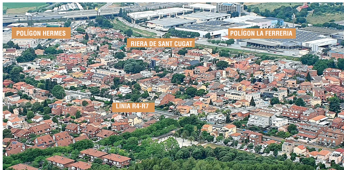
La zona 15 de Terra Nostra, entre l'R4 i la riera de Sant Cugat, és el sector urbà més inundable del municipi, segons assenyalava l'ACA
