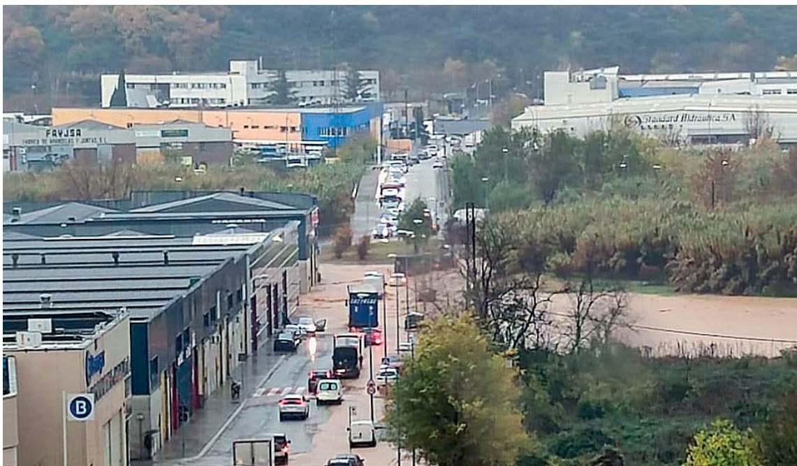
El torrent de Mas Duran es va desbordar provocant la inundació del punt on desemboca al Ripoll, i on hi ha tres polígons industrials
