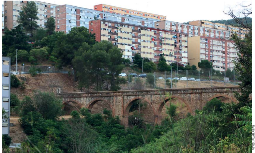
L'antic aqüeducte, que data del 1860, es transformarà en una passarel·la de vianants que comunicarà ambdós barris
