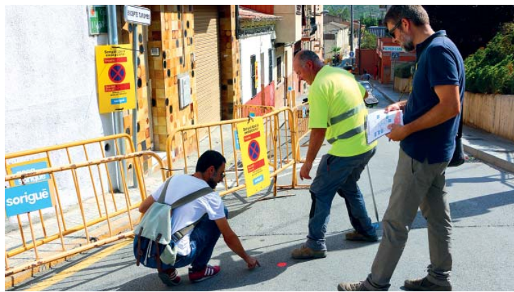
El president de l'Àrea Territorial, a la dreta, va visitar el c. Diagonal prèviament a l'inici de les obres
