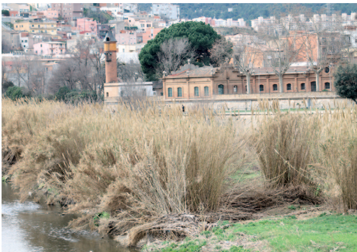
Vistes de la Casa de les Aigües, des de la qual es podrà accedir a la llera quan es faci realitat el passeig fluvial del Besòs fins a La Ribera
