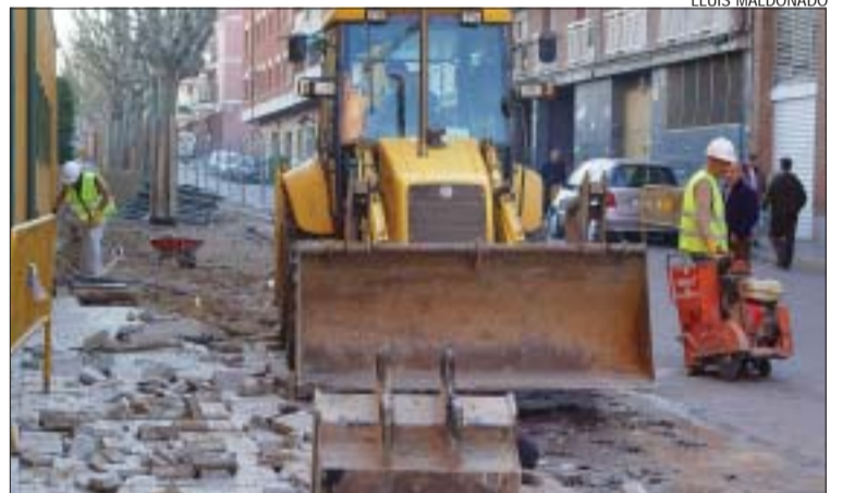
>> Les obres han començat entre el carrer Nord i la placeta
