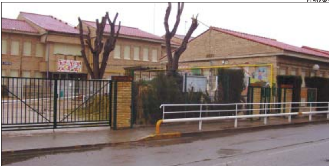
&gt;&gt; L'edifici que actualment ocupa la direcció del CEIP Mitja Costa, a la dreta, acollirà l'escola bressol
