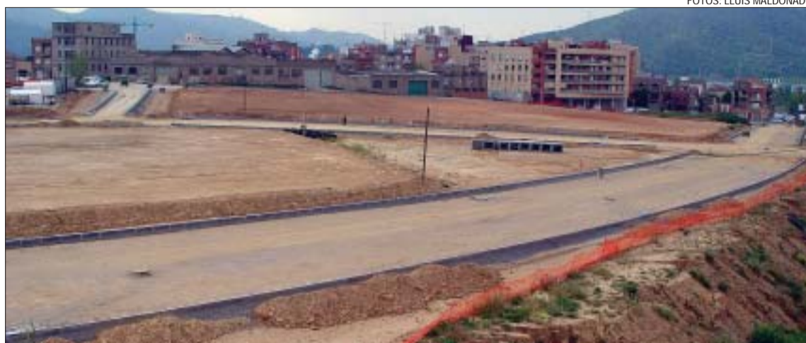
>> Vista parcial de les obres d'urbanització des de Mas Duran
