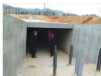
>> Imatge de les obres
