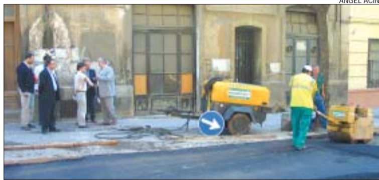
>> Obres del primer pas de la segona fase, a Carretera Vella
