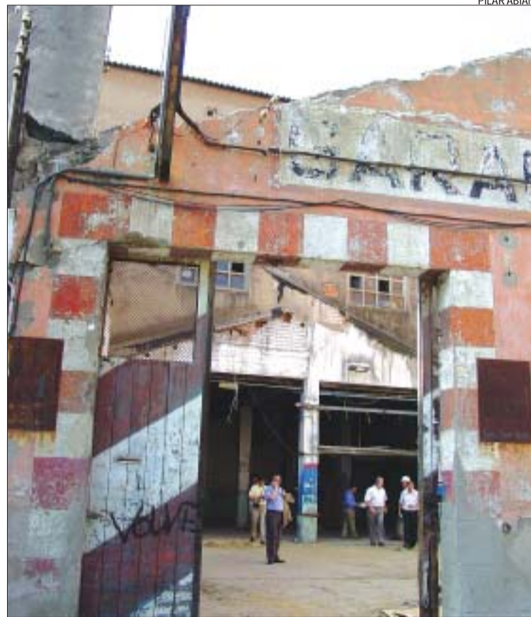
>> La façana i l'edifici el mateix dia abans de començar l'enderroc
