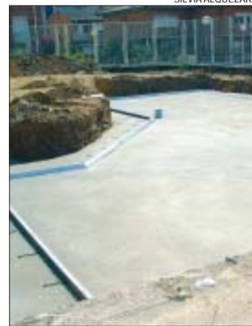
>> Obres de la piscina exterior
