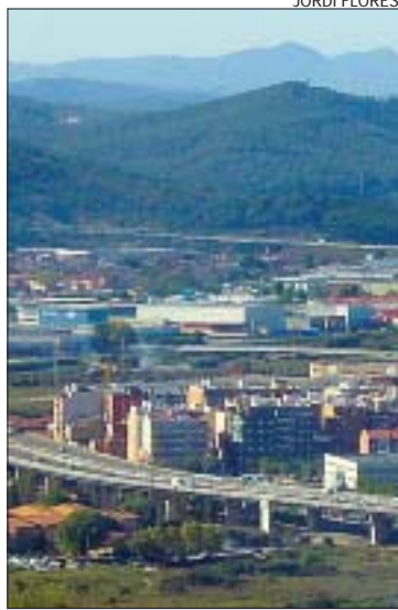
&gt;&gt; Vista aèria de la C-33
