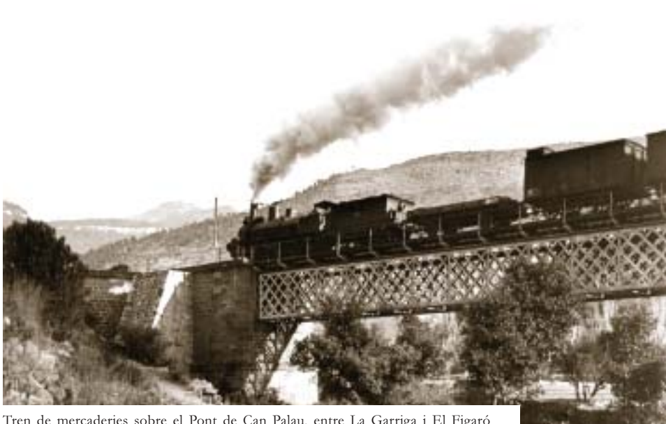
Tren de mercaderies sobre el Pont de Can Palau, entre La Garriga i El Figaró
