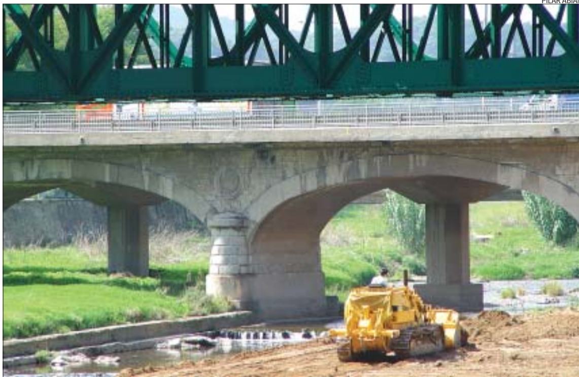
>> Neteja de la llera a l'alçada del pont de la C-17, a pocs metres de la riera de Sant Cugat
