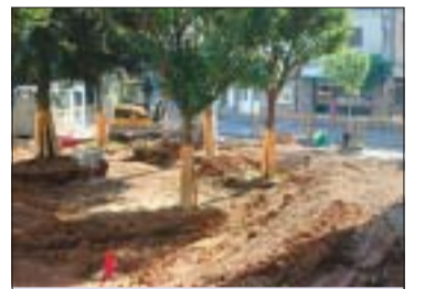
&gt;&gt; Obres a la plaça Salvador Espriu
