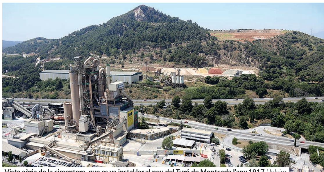
Vista aèria de la cimentera, que es va instal·lar al peu del Turó de Montcada l'any 1917 Holcim
