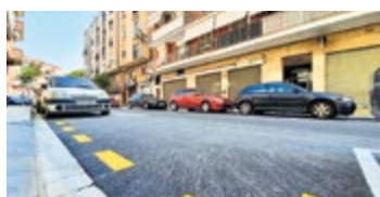
Renovar l'asfaltat i millorar les voreres
